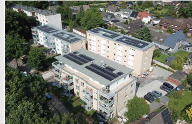
Bereits im Mai 2025 konnte der Neubau an der Langehegge mit 14 modernen Wohnungen inklusive PV-Anlage bezogen werden.
