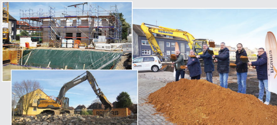
Das Neubau-Großprojekt "In den Gärten" schafft insgesamt 33 Wohnungen in Alt Marl.
