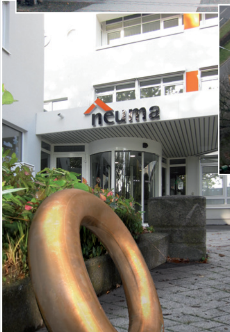
Im Jahre 1994 bezog die neuma das neue Verwaltungsgebäude in direkter Nähe zum Stadtzentrum an der Willy-Brandt-Allee.
