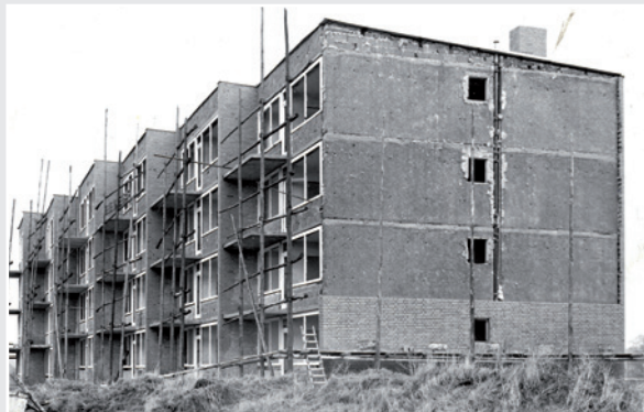
Gerüstbauweise in den 50ern, hier am Nonnenbusch.
