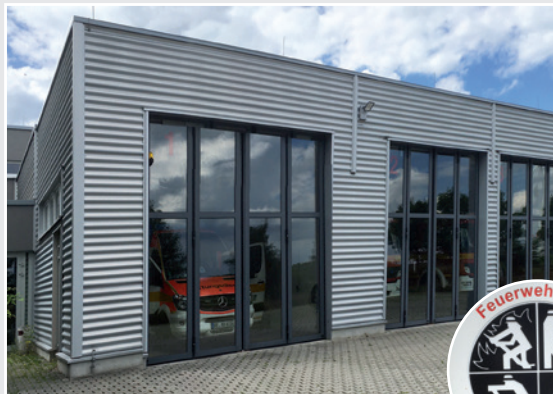
In Sinslen entstand im Rahmen eines Investorenmodells das neue Feuerwehrhaus.
