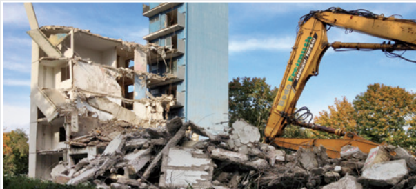
2015/2016 wurden die drei Hochhäuser an der Max-Reger-Straße abgerissen ...
