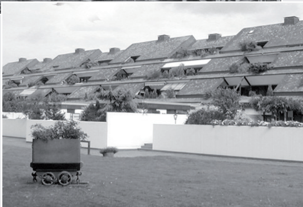
Das erste Hügelhaus an der Kreuzstraße findet in Bau-fachkreisen große Beachtung.
