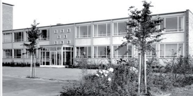
Das Verwaltungsgebäude der neuma an der Langehegge.
