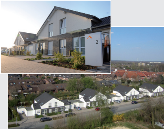
An der Siegerlandstraße entstanden 12 Winkelhäuser.
