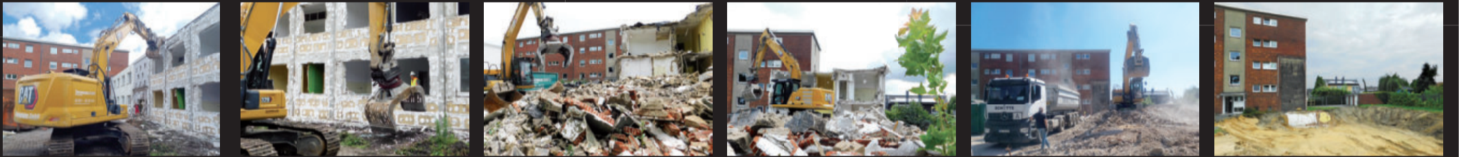
Mehrere Wochen dauerte der Abriss des alten Wohnhauses an der Langehegge und dann war endlich Platz für den schicken Neubau.
