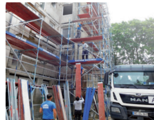
Bei den Modernisierungsarbeiten an der Glatzer Straße ging es richtig zur Sache.
