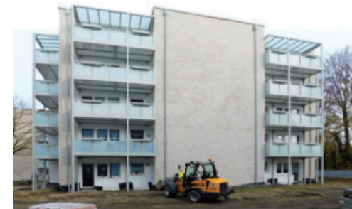
Blick auf die neuen großen Balkone, die alle Mieter toll finden.
