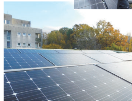
In nur zwei Wochen wurde die neue PV-Anlage auf dem neuma Verwaltungsgebäude installiert.
