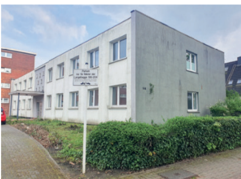
Das ehemalige neuma Verwaltungsgebäude wird bald abgerissen.
