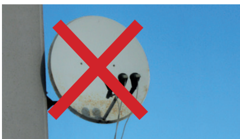
An den neuma Gebäuden dürfen generell keine Satellitenschüsseln angebracht werden.
