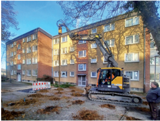
Mit einem acht Meter langen Bohrer wurden rund 80 Löcher in den Boden vor den Häusern gebohrt.
