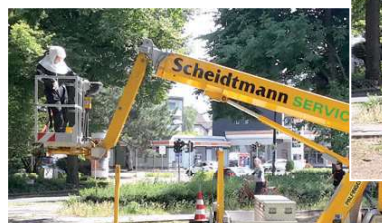
Sicher eingepackt wurden die Arbeiten fachmännisch ausgeführt.
