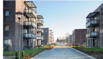
Während im vorderen Teil schon die Mieter eingezogen sind, wird in Richtung Süden noch kräftig gearbeitet.
