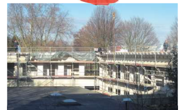
Schon bald sollen die Fenster eingebaut werden.
