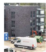
Im Einsatz auf der neuma Baustelle an der Clara-Wieck-Straße.
