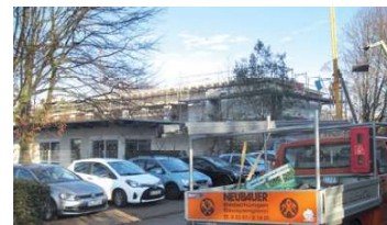
Die Dacharbeiten an der neuen Kita sind mittlerweile abgeschlossen.
