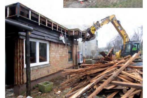
Der Abrissbagger leistete ganze Arbeit und die Gaststätte Bierkiste war einmal
