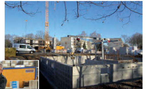
Der Keller von Haus 2 ist schon fertig
