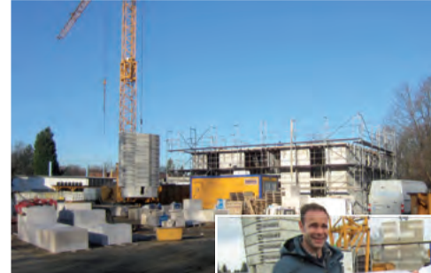
Haus 1 wächst in die Höhe
