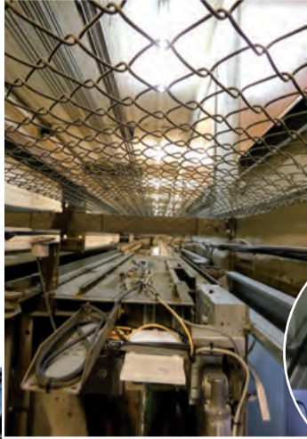
Blick in den 47 Meter tiefen Aufzugsschacht und auf die dicken Stahlseile, an denen die Kabine hängt
