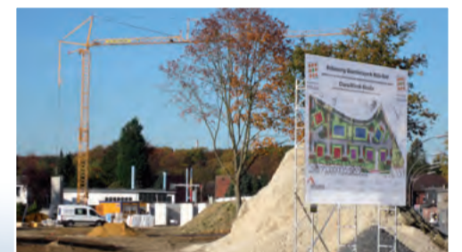
Schon bald nach dem ersten Spatenstich drehte sich der Baukran
