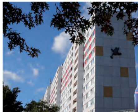
Im höchsten Wohnhaus der neuma achten Hausmeister Heinrich Sitzer (li.) und ThyssenKrupp Mitarbeiter Dirk Piotrowski auf den sicheren Betrieb der Aufzüge
